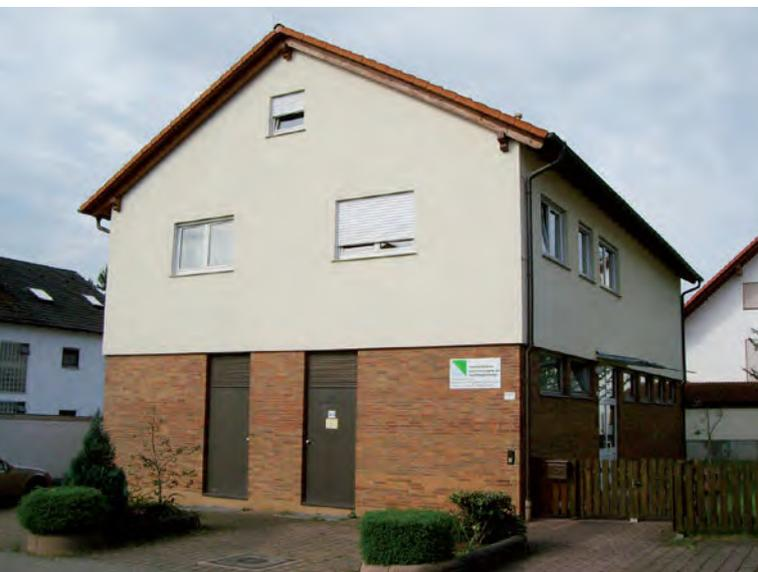
▲ Die Pumpstation Goldbach bestand zunächst aus dem Rohrkeller und dem Erdgeschoss, in welchem die Pumpen installiert sind. Die Aufstockung erfolgte erst von 1994 bis 1995 zur Unterbringung der Betriebs- und Schaltzentrale. Das Gebäude wurde der dort vorhandenen Wohnhausbebauung angepasst.
