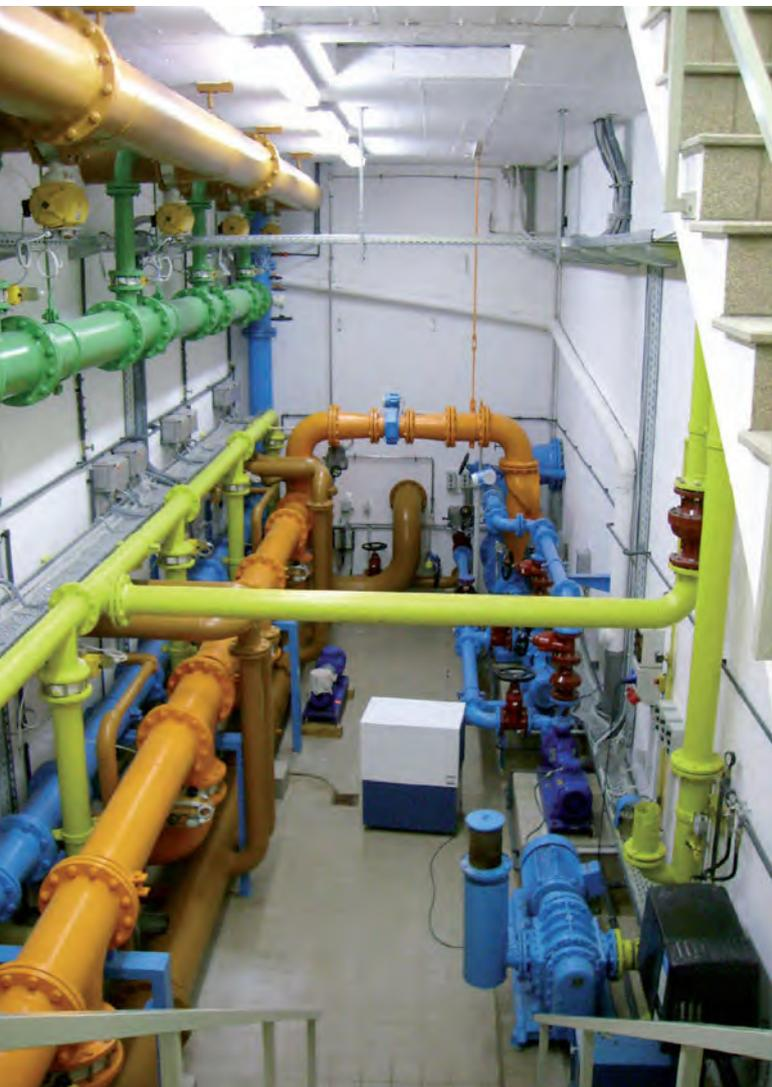
▲ Jedes Filterbecken ist einzeln an die Rohwasser-, Reinwasser-, Spülwasser-, Spülluft- und Schlammwasser-Ableitungen angeschlossen (Farbunterschiede der Leitungen)
