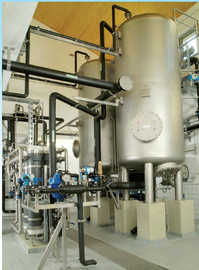
▲ Die beiden Entsäuerungsfilter aus Edelstahl reichen vom Rohrkeller bis unter die Dachschräge.
